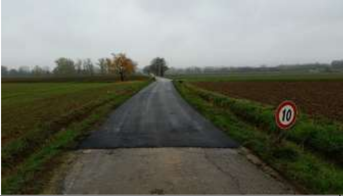
Località Masana: terminati lavori di bitumatura (26/11/2016)
