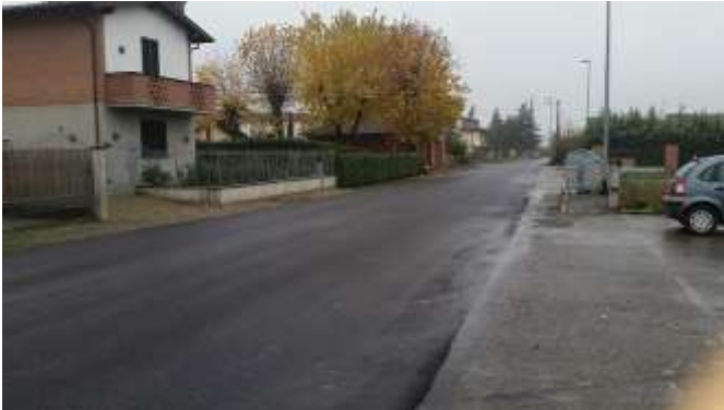
Frazione Chero: ripristinate alcune porzioni di asfalto (26/11/2016)
