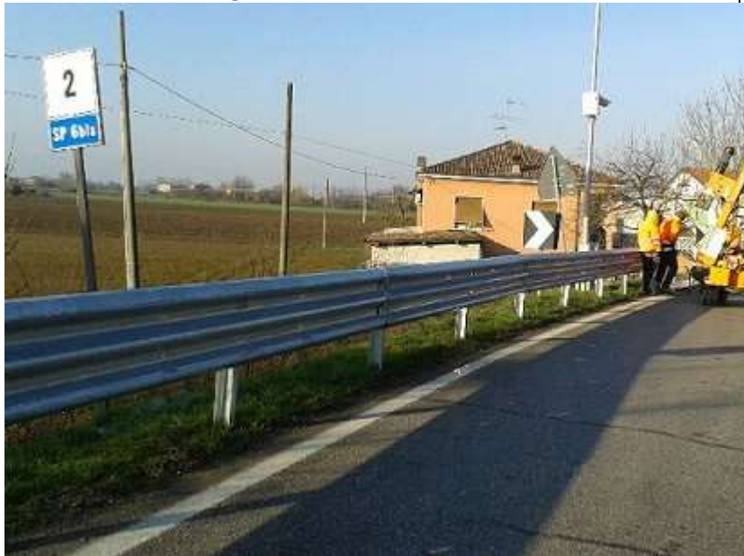
Messa in sicurezza ingresso frazione Ciriano (10/12/2016)
